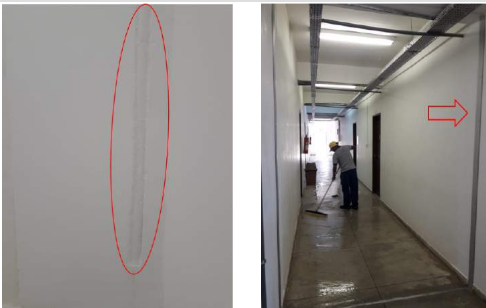
Figura 6: Reparo em junta de dilatação
