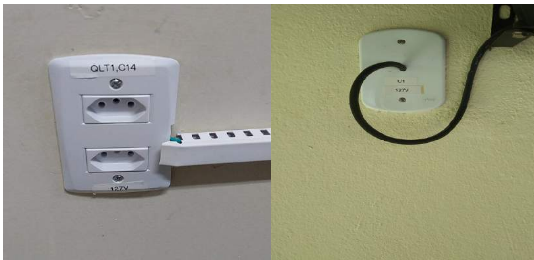
Figura 34: Manutenção de tomadas e identificação de circuito e tensão elétrica.
