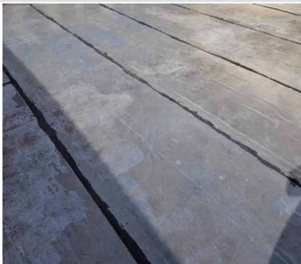
Figura 8: Laje impermeabilizada da cobertura usando manta asfáltica com filme de polietileno - Unidade III/Campus Marabá
