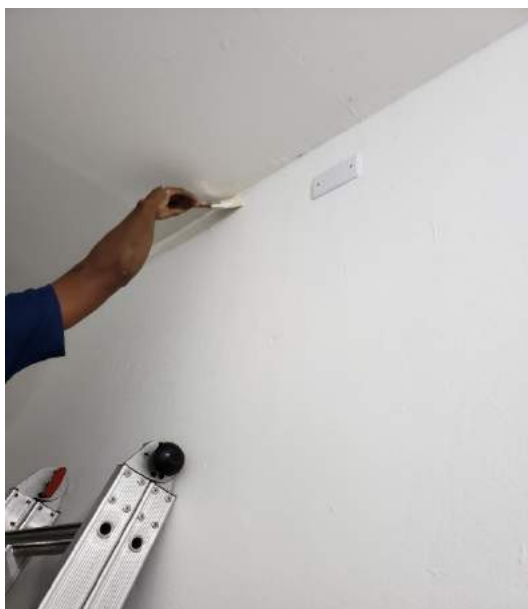
Figura 4: Paredes internas recuperadas
