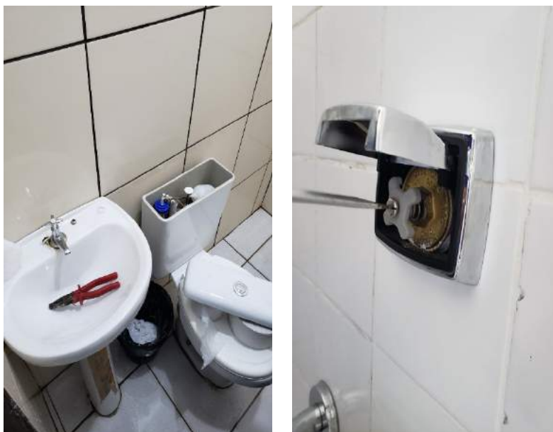
Figura 22: Manutenção nas descargas da caixa acoplada e na válvula de descarga de parede.
