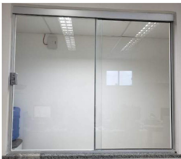
Figura 10: Janelas com esquadria em alumínio
