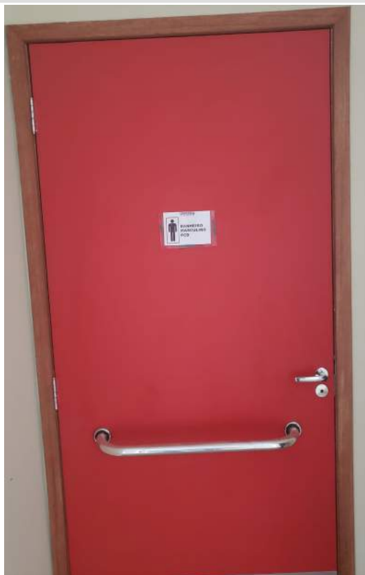
Figura 11: Portas dos sanitários PNE com barra metálica
