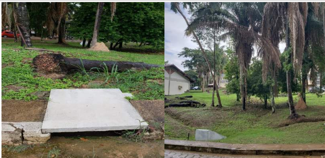
Figura 37: Meio fio com boca de lobo
