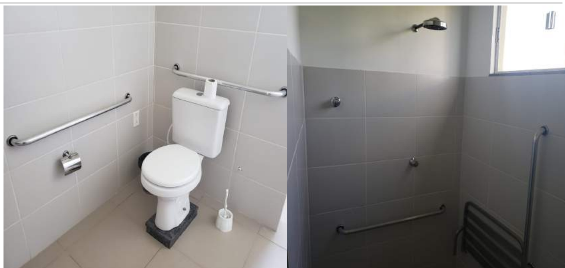
Figura 24: Banheiros PNE das novas edificações, de acordo com as normas de acessibilidade
