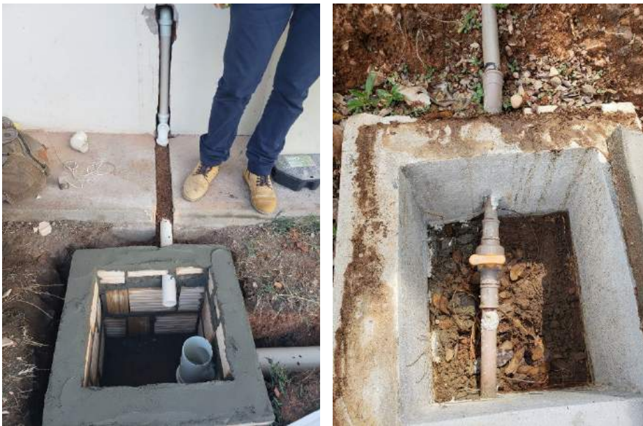
Figura 26: Construção de Caixa de Gordura e vistória em caixa de manobra.
