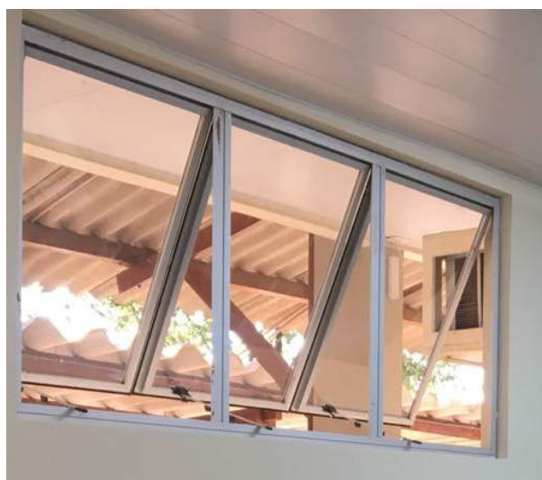
Figura 10: Janelas com esquadria em alumínio
