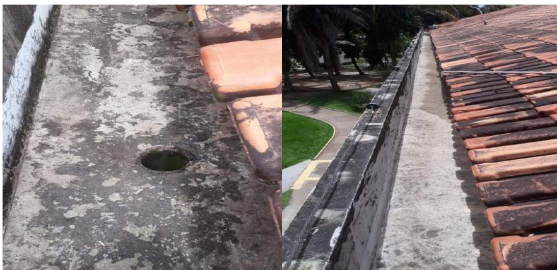
Figura 29: Calha e tubo de queda após limpeza e antes da impermeabilização
