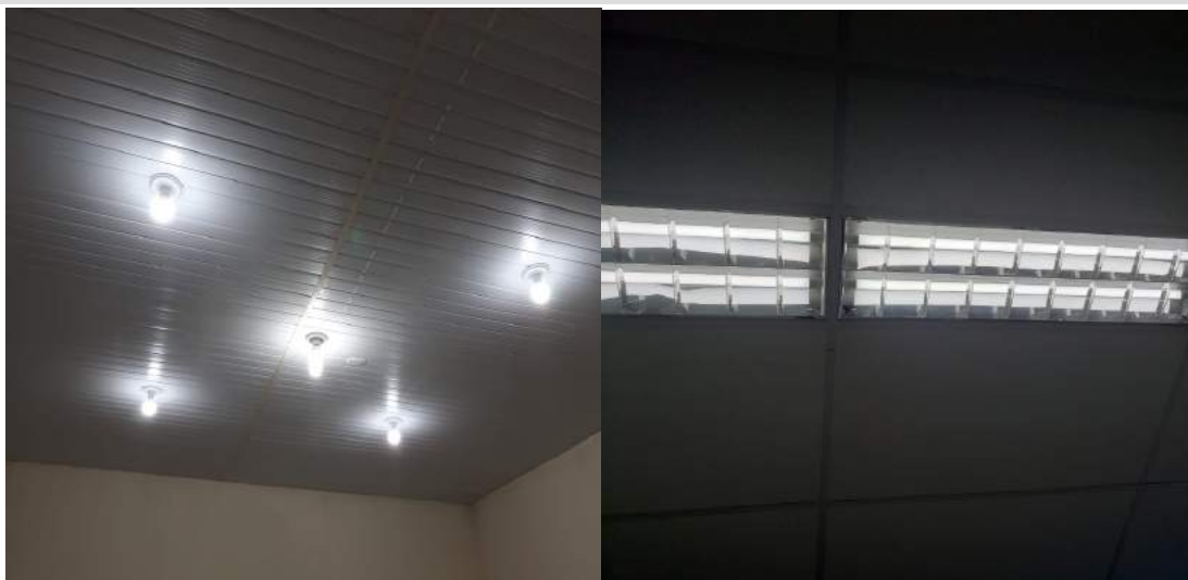
Figura 31: Luminárias de LED tubular e de bulbo
