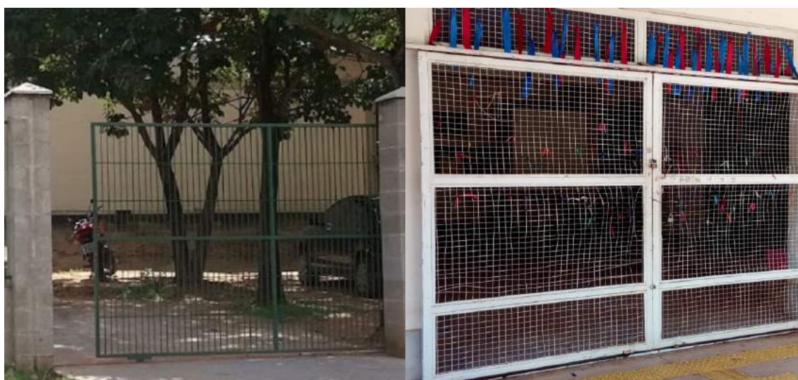
Figura 14: Portões de acesso à estacionamento e biblioteca respectivamente – Campus Xinguara e Campus Marabá
