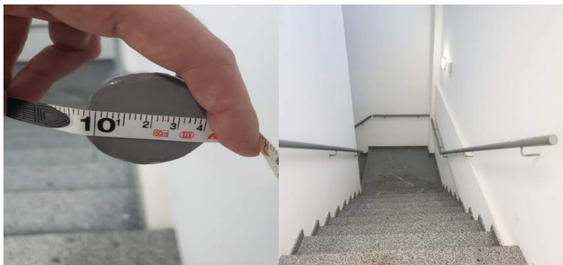
Figura 18: Corrimão de acesso aos pavimentos.
