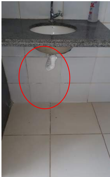
Figura 23: Reparo em tubulação e substituição de azulejo.
