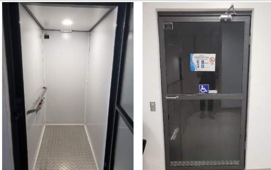
Figura 19: Elevadores do tipo plataforma PNE.
