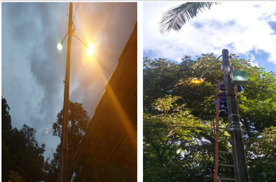
Figura 33: Manutenção de iluminação externa, que passarão pelo “retrofit”
