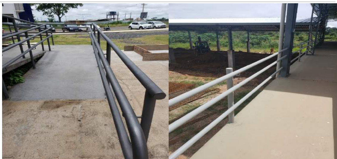
Figura 17: Corrimão para acessibilidade as edificações
