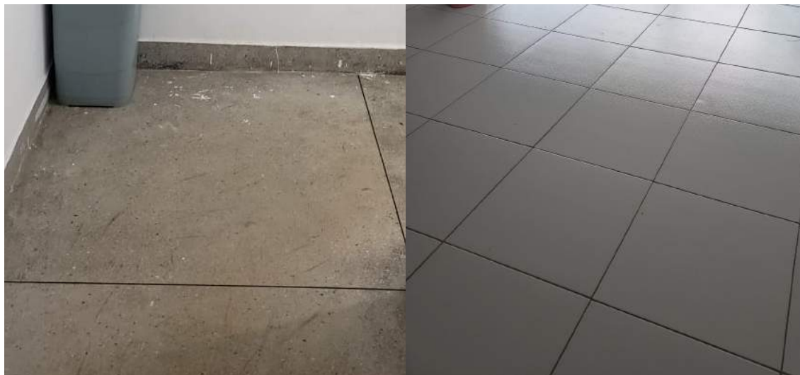
Figura 15: Piso em granitina e com lajota antiderrapante
